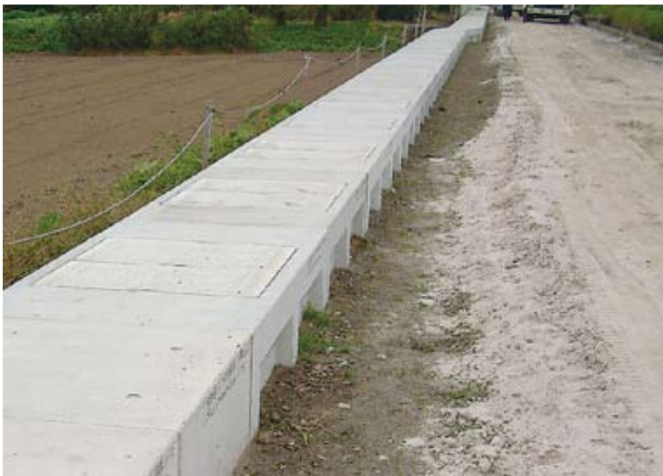
■片土圧による土留工法
