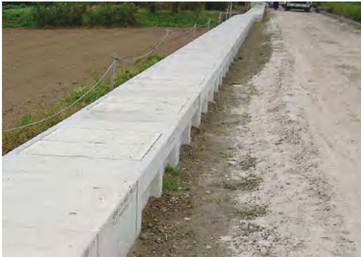
■片土圧による土留工法
