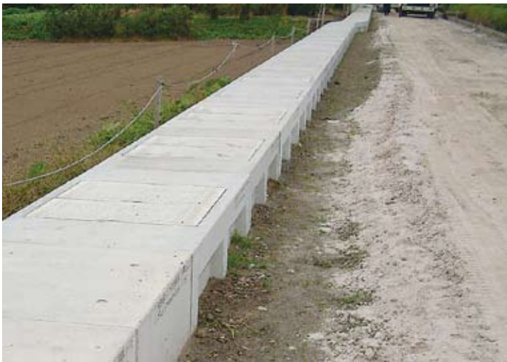
■片土圧による土留工法
