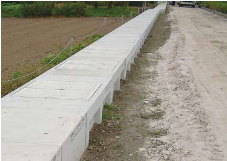
■片土圧による土留工法
