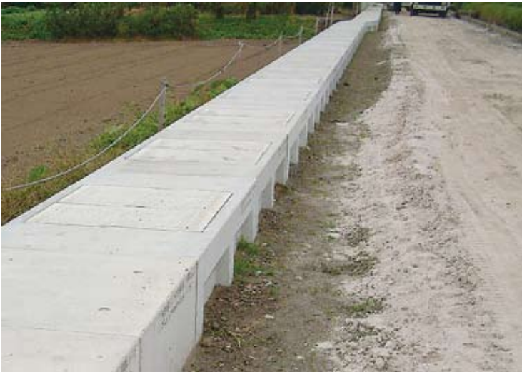
■片土圧による土留工法
