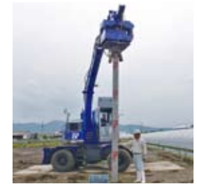
施工機械 油圧パイプ超高速微動マシーン
