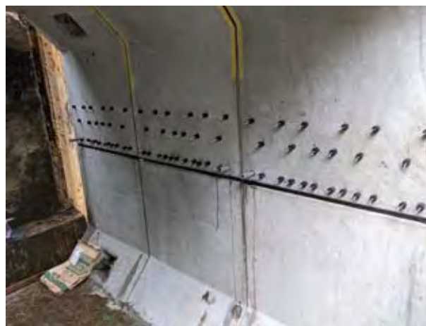
▲モルタル充填後
