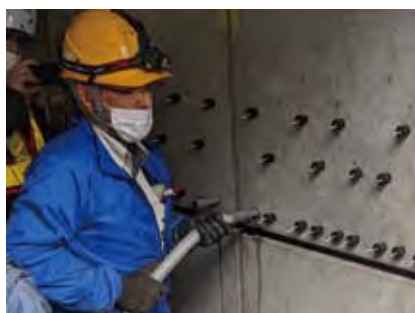
▲モルタル充填状況
