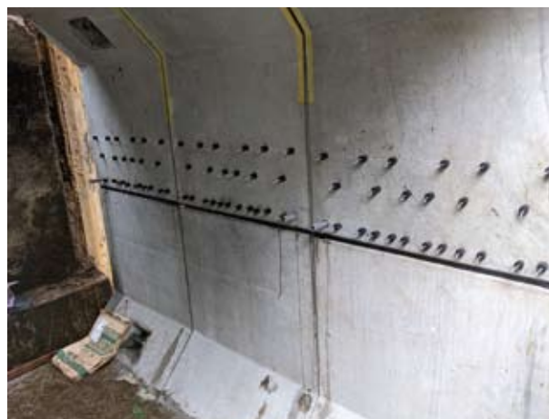
▲モルタル充填後
