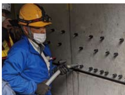
▲モルタル充填状況
