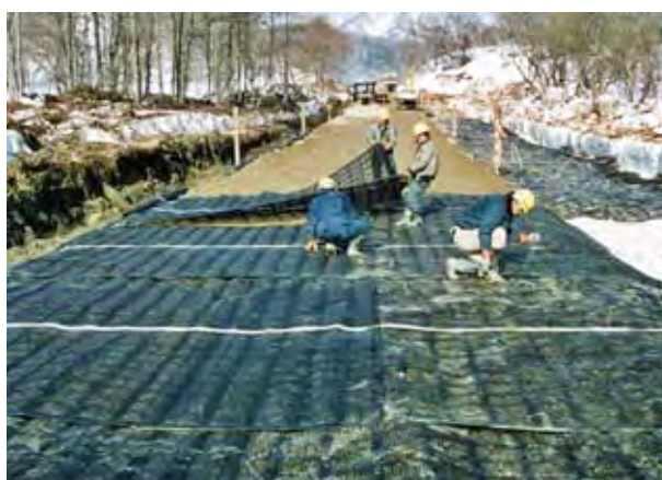
軟弱地盤において不同沈下を防ぐ
