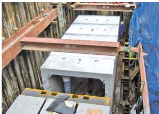
▼アンダーパス非開削施工R&C工法1
