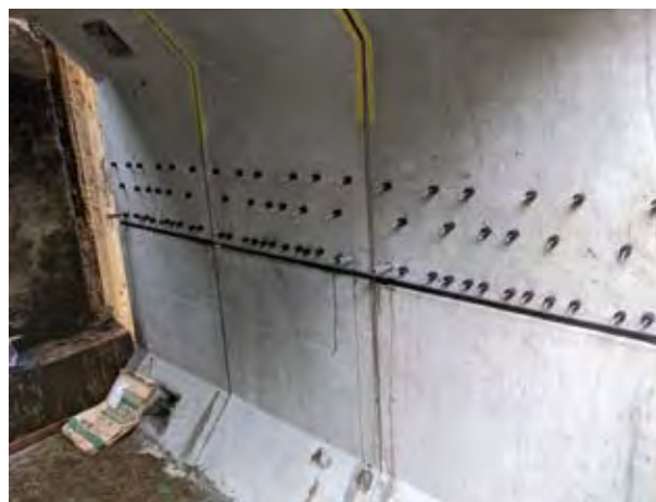
▲モルタル充填後
