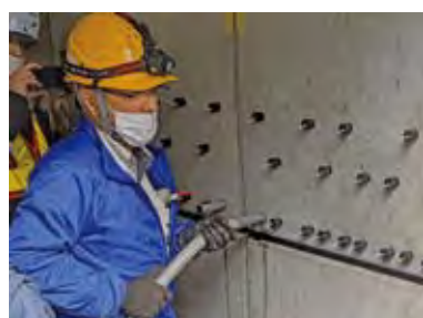
▲モルタル充填状況
