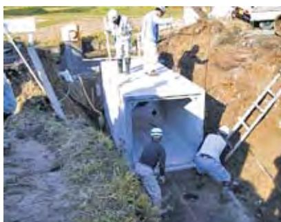
5. 普通型を据付
