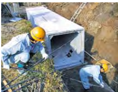
7. PC鋼より線を4穴に通す
