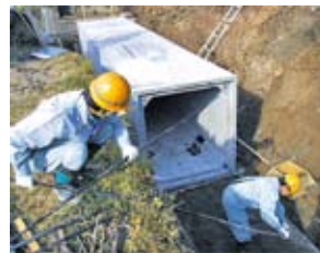
7. PC鋼より線を4穴に通す
