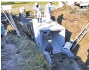
5. 普通型を据付
