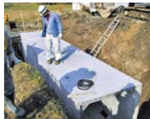
6. カップリング付ボックスを終端に据付
