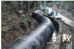
▲上水道管(誘導管)
