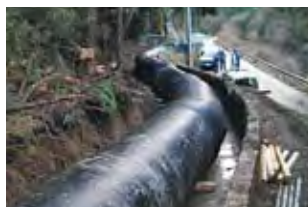
▲上水道管(誘導管)
