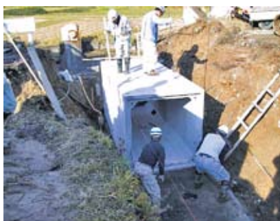
5. 普通型を据付
