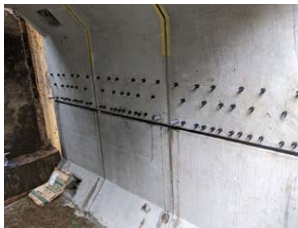
▲モルタル充填後
