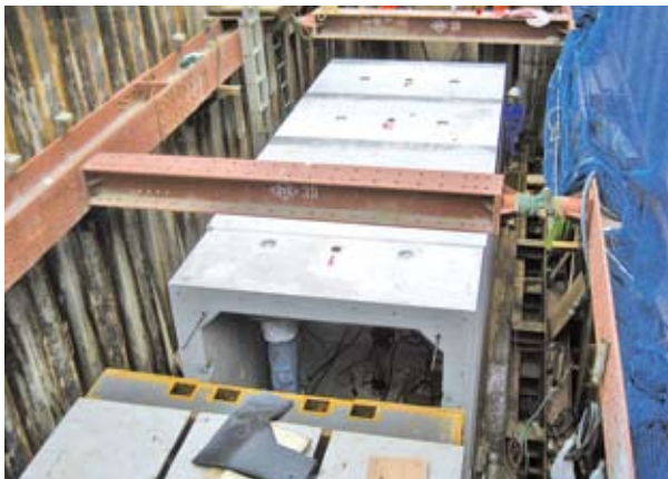
▼アンダーパス非開削施工R&C工法1
