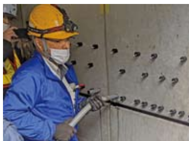
▲モルタル充填状況
