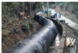
▲上水道管(誘導管)
