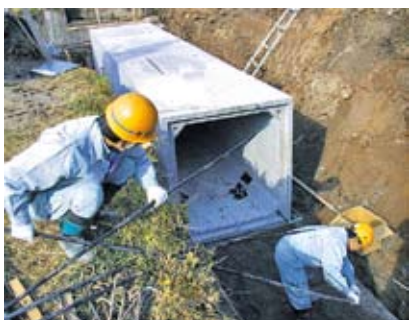
7. PC鋼より線を4穴に通す
