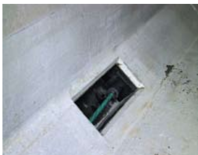
8. 最初のカップリング付ボックスにPC鋼より線を定着
