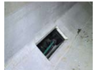
8. 最初のカップリング付ボックスにPC鋼より線を定着
