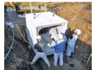
4. カップリング付ボックスを最初に据付
