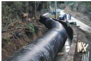
▲上水道管(誘導管)
