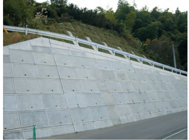
標準ブロック(かさね積みもたれ式擁壁)
