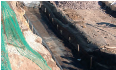
1.かごテンサー基礎敷設
