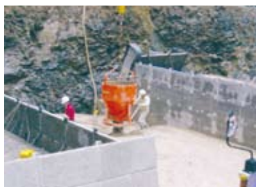
5. コンクリート打設状況
