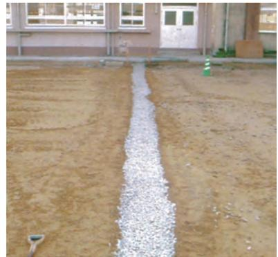
地下構造物への鉛直土圧の軽減および不等沈下対策
