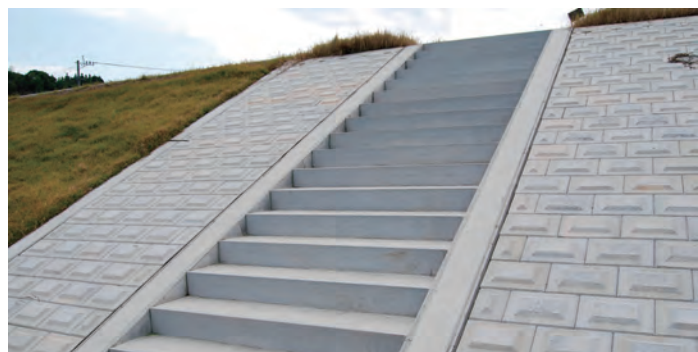
▲仙台東部道路のり面管理用通路設置工▲
