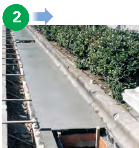
コンクリート打設
