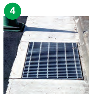
グレーチング設置
