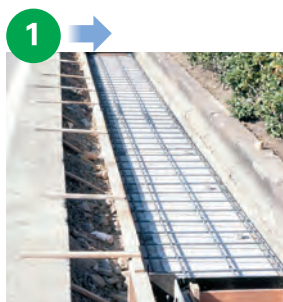
KCフォームの上に配筋した状態
