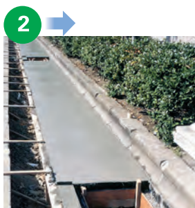
コンクリート打設
