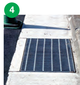
グレーチング設置
