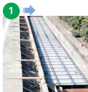
KCフォームの上に配筋した状態
