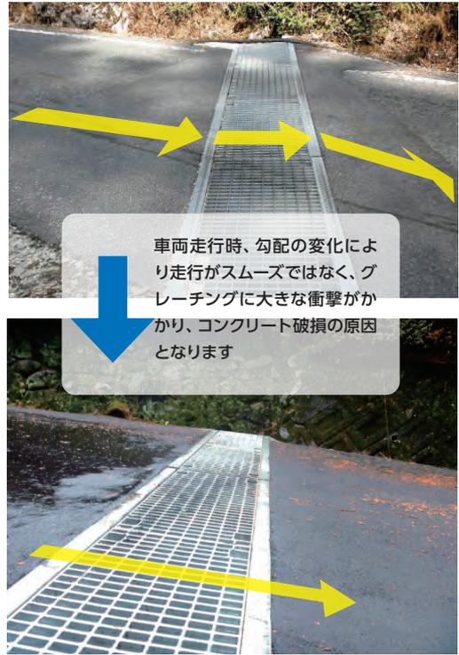
車両走行時、勾配の変化により走行がスムーズではなく、グレーチングに大きな衝撃がかかり、コンクリート破損の原因となります
