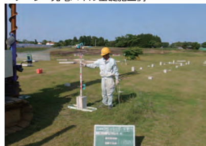
▼ソーラー発電パネル基礎施工例
