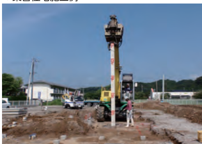
▼集合住宅施工例
