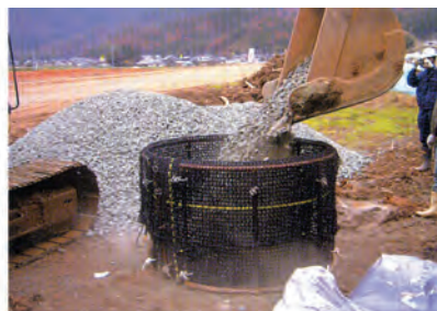
②中詰め材投入
