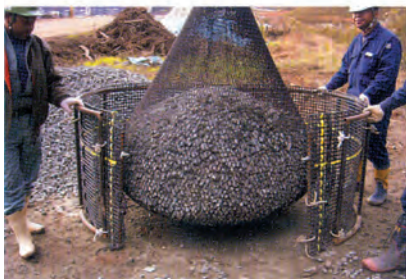
④型枠開放
