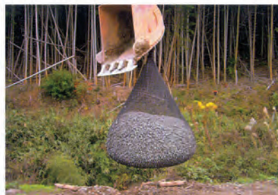
⑤吊上げ移動
