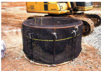
①袋材設置 (袋の底が少し浮く位に設置)
