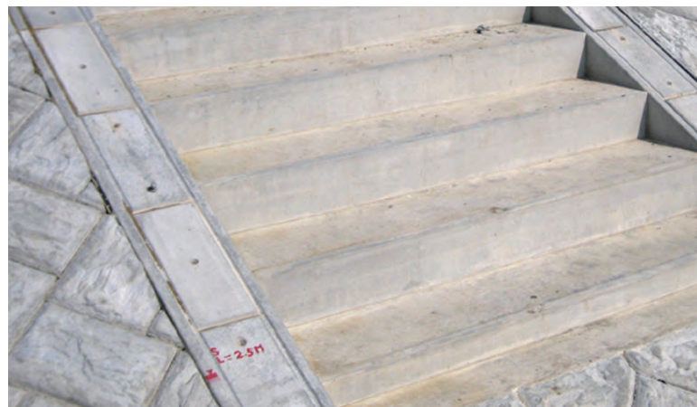
▲階段端部止工
