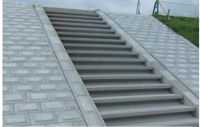
基本型 参考重量=400kg 充填コンクリート量:0.208m<sup>3</sup>
