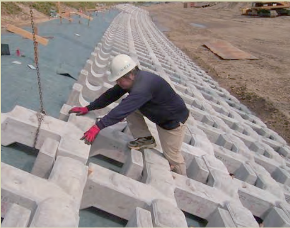
ブロックを単体で施工します。
