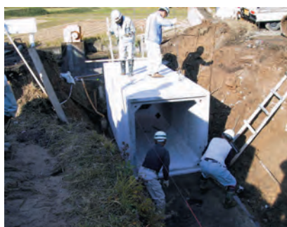
5. 普通型を据付
