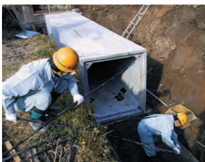
7. PC鋼より線を4穴に通す
