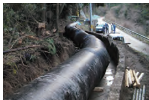
▲上水道管(誘導管)
