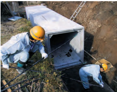
7. PC鋼より線を4穴に通す
