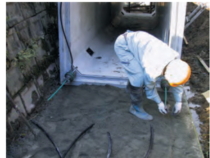
9. 最後のカップリング付ボックスに緊張用ジャッキをセット
