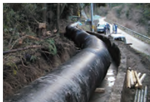
▲上水道管(誘導管)
