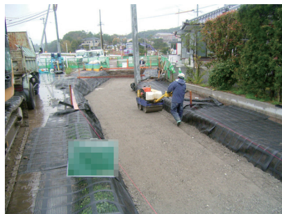
▲L型擁壁の基礎地盤補強の採用事例。農耕地に隣接しているため、コンクリートによる地盤改良が行えず、周囲の環境に影響を与えないジオグリッドを用いた「マットレス工法」が採用になりました。
