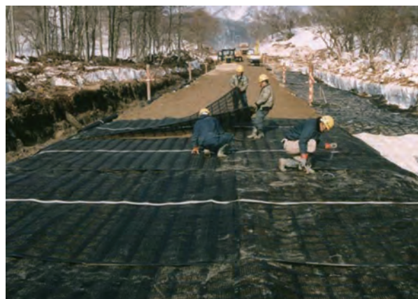
▲軟弱地盤において不同沈下を防ぐ
