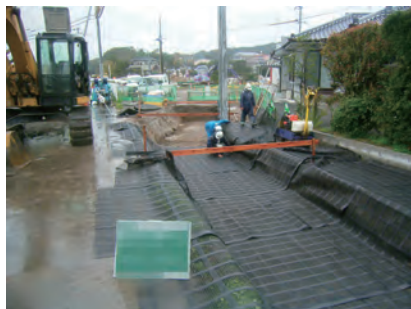
▲I型擁壁の基礎地盤補強の採用事例。農耕地に隣接しているため、コンクリートによる地盤改良が行えず、周囲の環境に影響を与えないジオグリッドを用いた「マットレス工法」が採用になりました。
