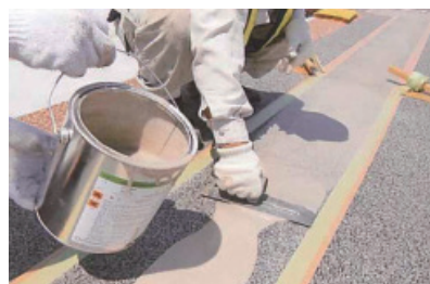
3. 専用接着剤の塗布・下塗り(シゴキ)
