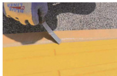
7. 点字タイル端部のテーパー処理
