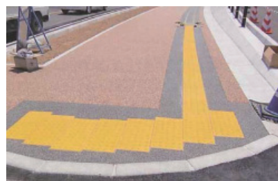
10. 完成(開放) 養生をとり、接着剤硬化を確認の上(冬期約90分 その他の季節約60分)解放します。
