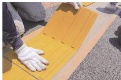
6. 点字タイルの貼付け
