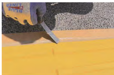
7. 点字タイル端部のテーパー処理
