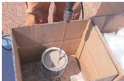
2. 専用接着剤の混合攪拌
