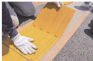
6. 点字タイルの貼付け
