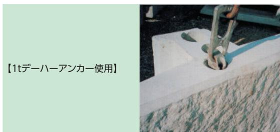
**■標準歩掛り** バランス工法擁壁 (10.0m<sup>2</sup>当り) トラッククレーン油圧式10~11t吊り据付180° 旋回可能場所
