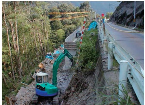
⑥擁壁断面 (現道を確保しながら施工ができます。)
