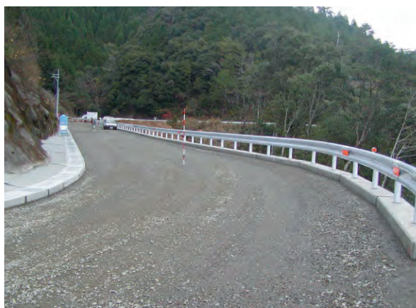
⑦完成直前天端部
