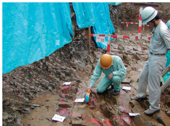
②地盤支持力確認
