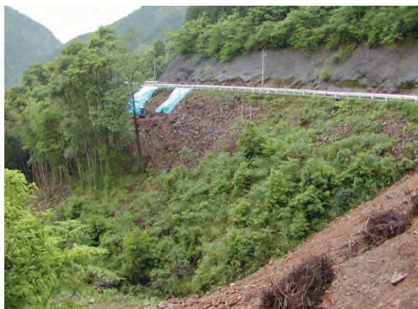
①工事着工前
