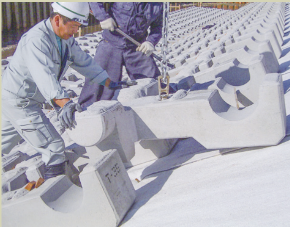
ブロックを単体で施工します。
