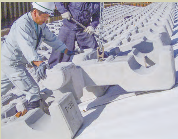
ブロックを単体で施工します。
