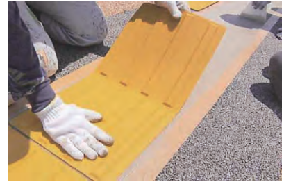
6. 点字タイルの貼付け
