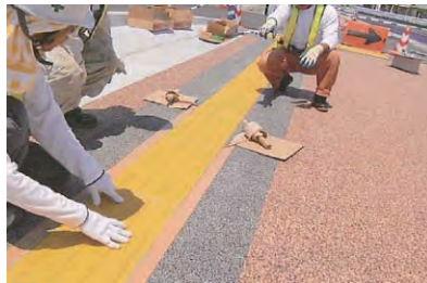
8. 通り(直線性)の確認
