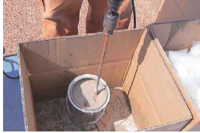
2. 専用接着剤の混合攪拌
