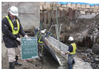
水中コンクリート打設状況
