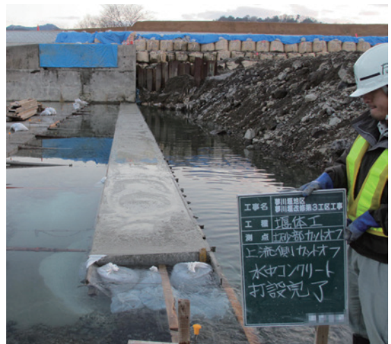
水中コンクリート打設完了
