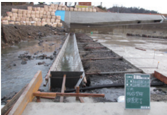
残存型枠設置完了
