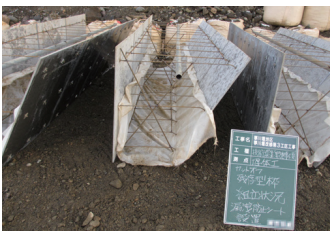
残存型枠設置完了
