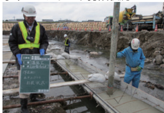
水中コンクリート打設状況
