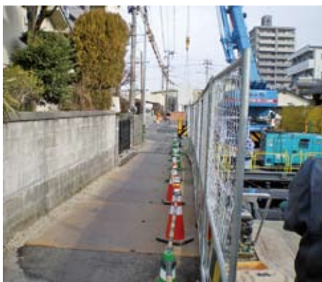
余裕の 施工幅
