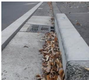
落葉の堆積時でも60mm/hの降雨強度で越流せず、安定した排水性を発揮します。
