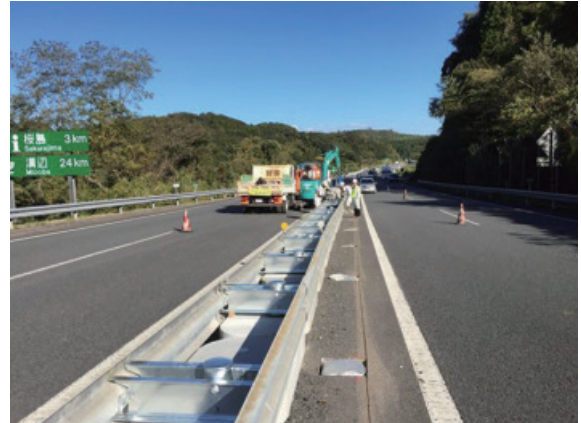
※九州自動車道床版取替え工事
