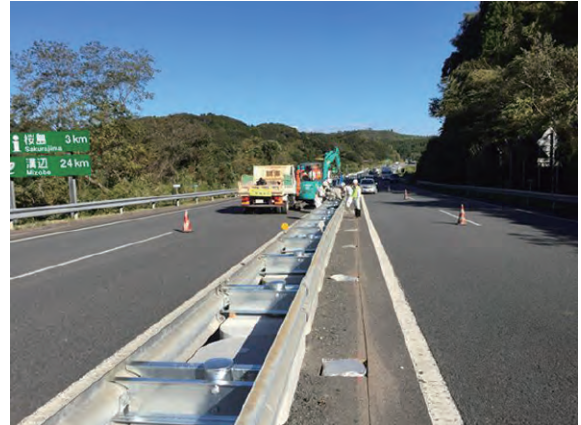
※九州自動車道床版取替え工事
