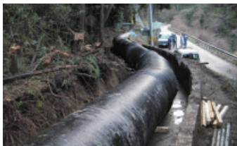
▲上水道管(誘導管)
