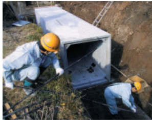
7. PC鋼より線を4穴に通す
