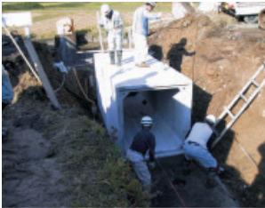
5. 普通型を据付
