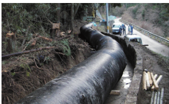
▲上水道管(誘導管)
