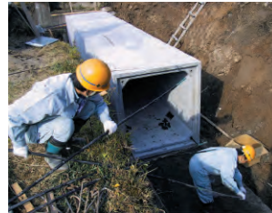
7. PC鋼より線を4穴に通す
