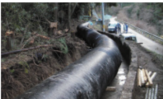
▲上水道管(誘導管)
