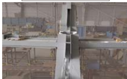
「マスマス整流ます」設置
