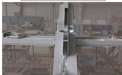
「マスマス整流ます」設置
