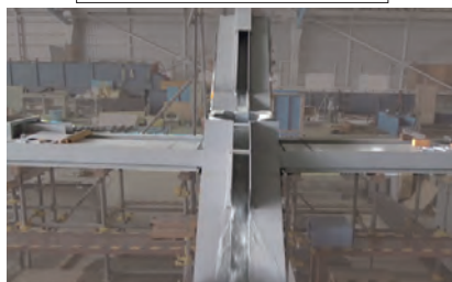
「マスマス整流ます」設置
