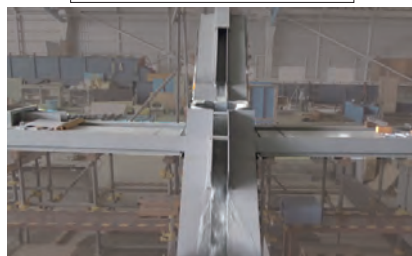
「マスマス整流ます」設置
